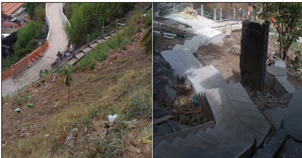
Ilustração 2 .Exemplo de melhorias de acessibilidade do programa Morar Carioca, no Morro da Providência. Fonte: Autor 1 (2013).
