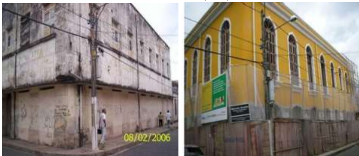
Fig. 2 - “recuperação” de imóvel na cidade de Belém (PA) financiado pelo PAC-Cidades Históricas. FONTE: IPHAN, 2014, P. 10
