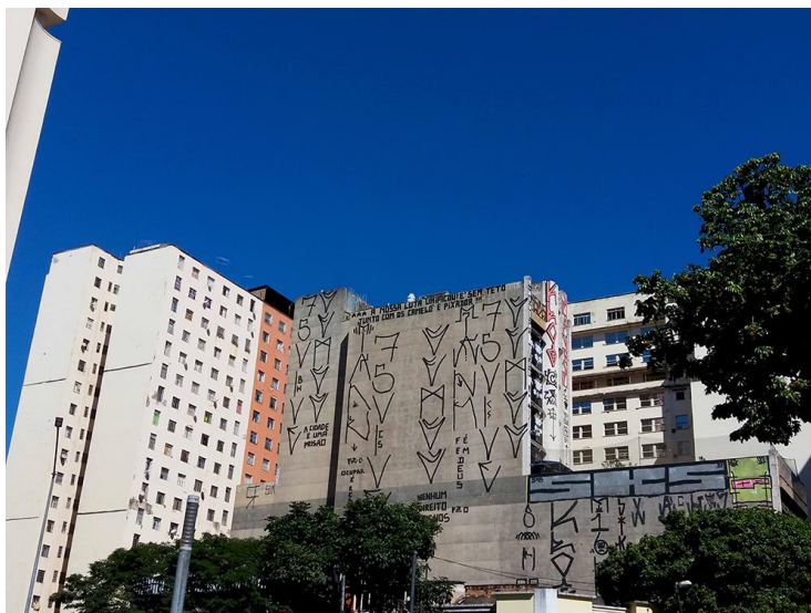
Figura 4: Edifício da Ocupação Vicentão e seu entorno imediato. É possível verificar nesta imagem as empenas cegas geradas com a construção do prédio nos limites do lote
