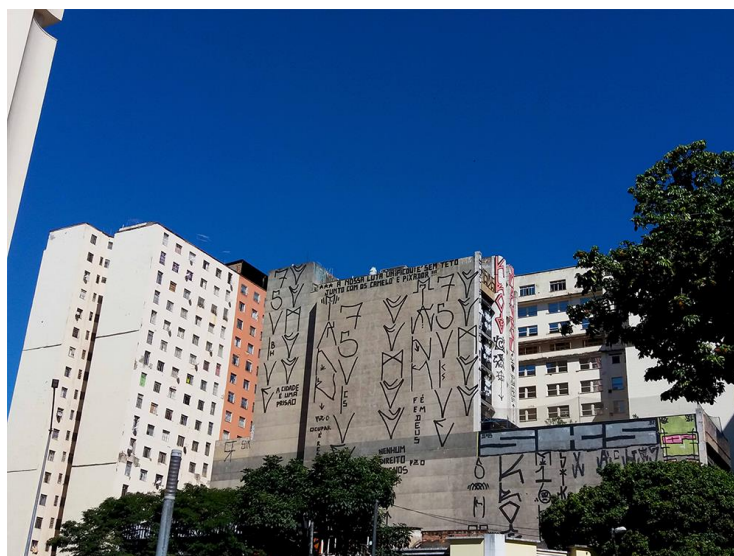
Figura 4: Edifício da Ocupação Vicentão e seu entorno imediato. É possível verificar nesta imagem as empenas cegas geradas com a construção do prédio nos limites do lote
