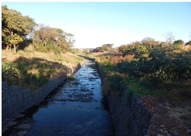
Figura 2 - Retificação/canalização no córrego Tamanduá. Fonte: Fotografia pelo autor, 2017.
