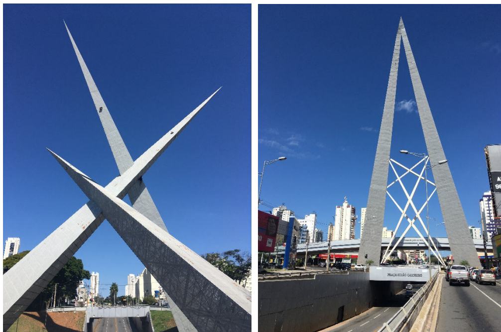
Figura 5 - A imagem da esquerda refere-se ao Viaduto Latif Sebba; e a imagem da direita refere-se ao Viaduto João Alvez Queiroz.
