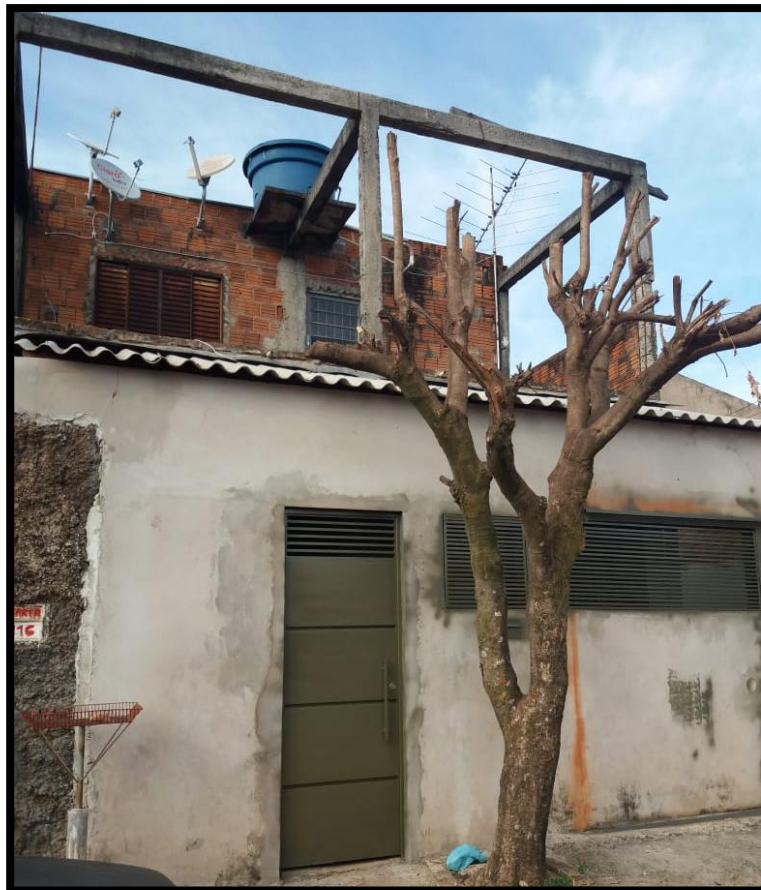
Figura 7: Autoconstrução em andamento, Jardim Niceia
