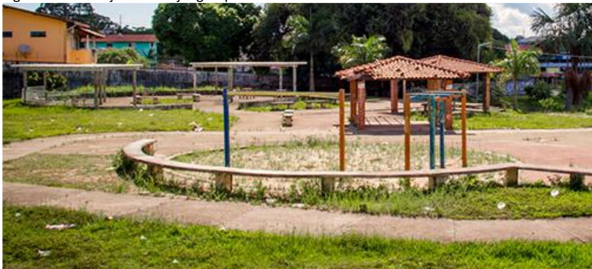
Figura 13 – Situação do Praça Igarapé do Bombeamento em Manaus-AM.
