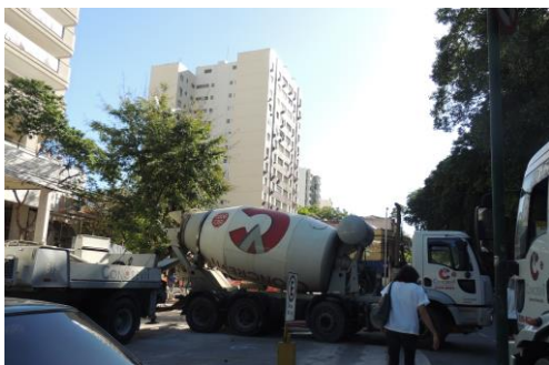
Figura 21. Foto da obra na zona 15.
