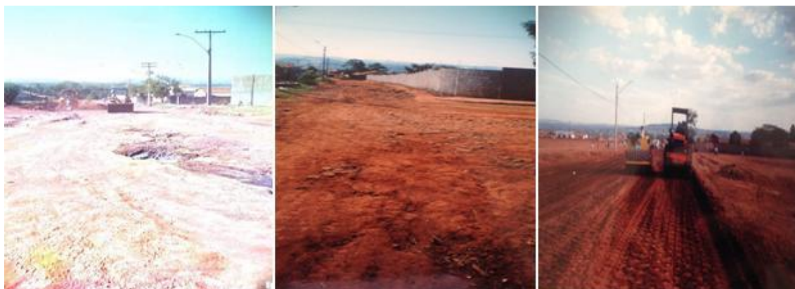
Figura 10: Pavimentação da Avenida Mangalô. Fonte: Oliveira, 2016 apud CORRÊA, Marcelo de Souza, 2000.
