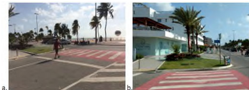
Figura 28: Faixa de pedestres com barreira na sua finalização.
