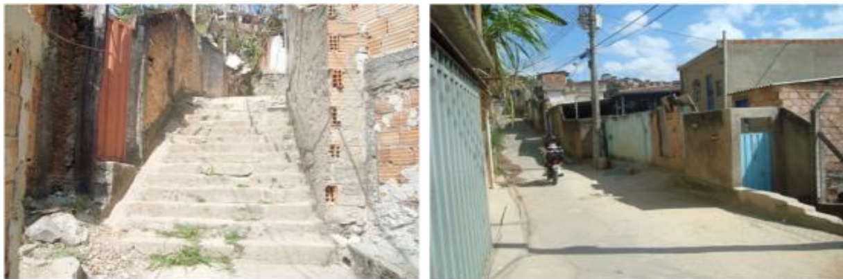
Figura 02 - Aspecto de vias internas na área de estudo com urbanização anterior à intervenção estruturante – Beco Murilo Rubião e Rua São Tomás (20/07/2013).
