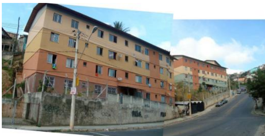
Figura 03 - Implantação dos edifícios habitacionais executados pela intervenção estruturante e paisagem típica da Avenida do Cardoso / Via 276 (10/09/2013)
