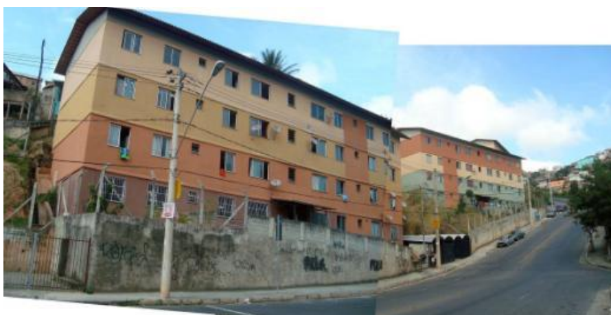
Figura 03 - Implantação dos edifícios habitacionais executados pela intervenção estruturante e paisagem típica da Avenida do Cardoso / Via 276 (10/09/2013)
