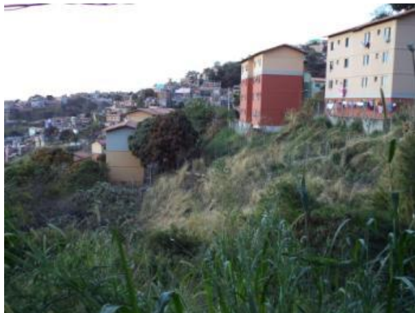
Figura 1 - Urbanização no limite de APP, falta de tratamento ambiental das encostas - encosta leste no talvegue da Segunda Água, hoje encontra-se reocupada informalmente (10/09/2013).
