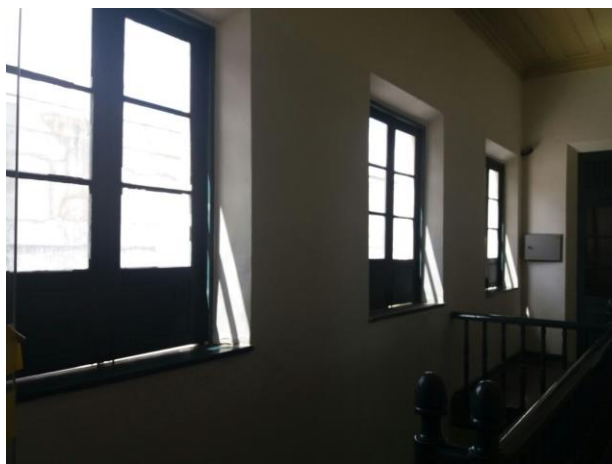
Figura 12- Janelas no segundo pavimento do Sobrado Dr. José Lourenço. Fonte: Autoral
