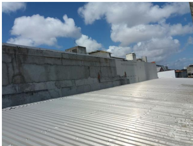
Figura 13- Vista dos telhados pelas Janelas no segundo pavimento do Sobrado Dr. José Lourenço. Fonte: Autoral
