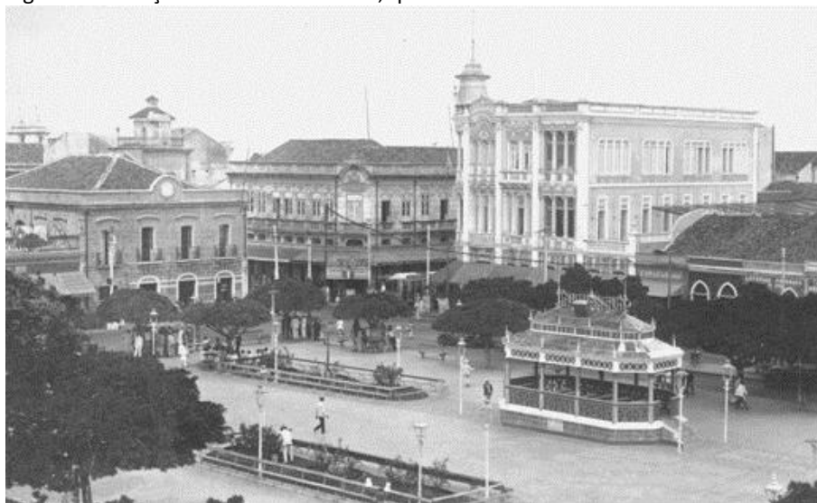
Figura 05 – Praça do Ferreira em 1925, quando foi construído o coreto de alvenaria.
