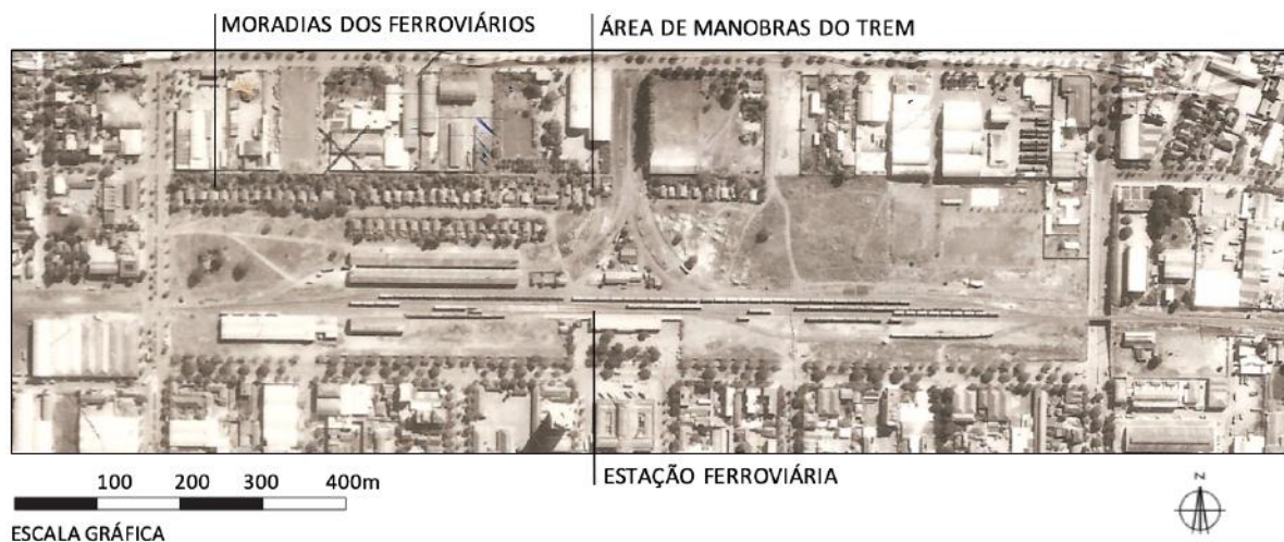
Figura 7: Pátio de manobras e estação ferroviária na década de 1980. Fonte: Acervo do Laboratório de Geoprocessamento, Departamento de Engenharia Civil-Universidade Estadual de Maringá.
