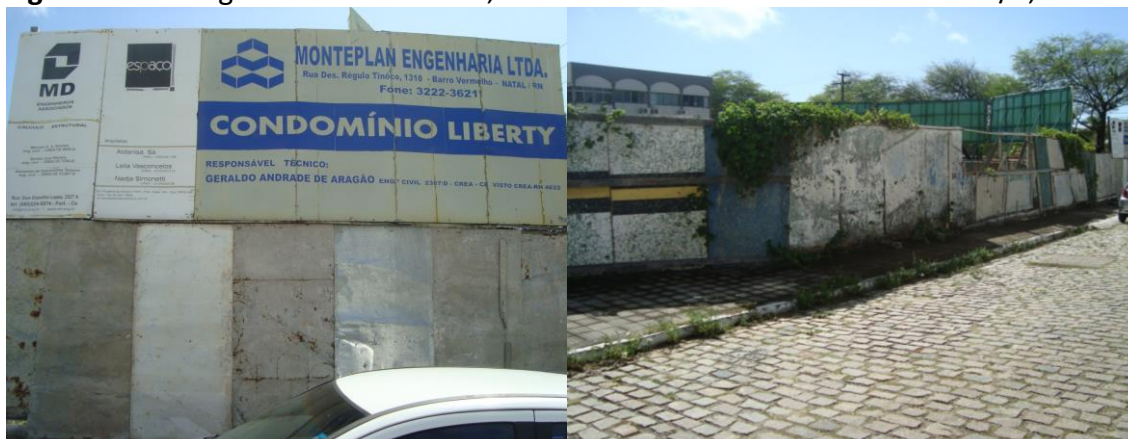
Figura 09 – Antigo Centro de Velório, localizado na Av. Hermes da Fonseca s/n, Tirol
