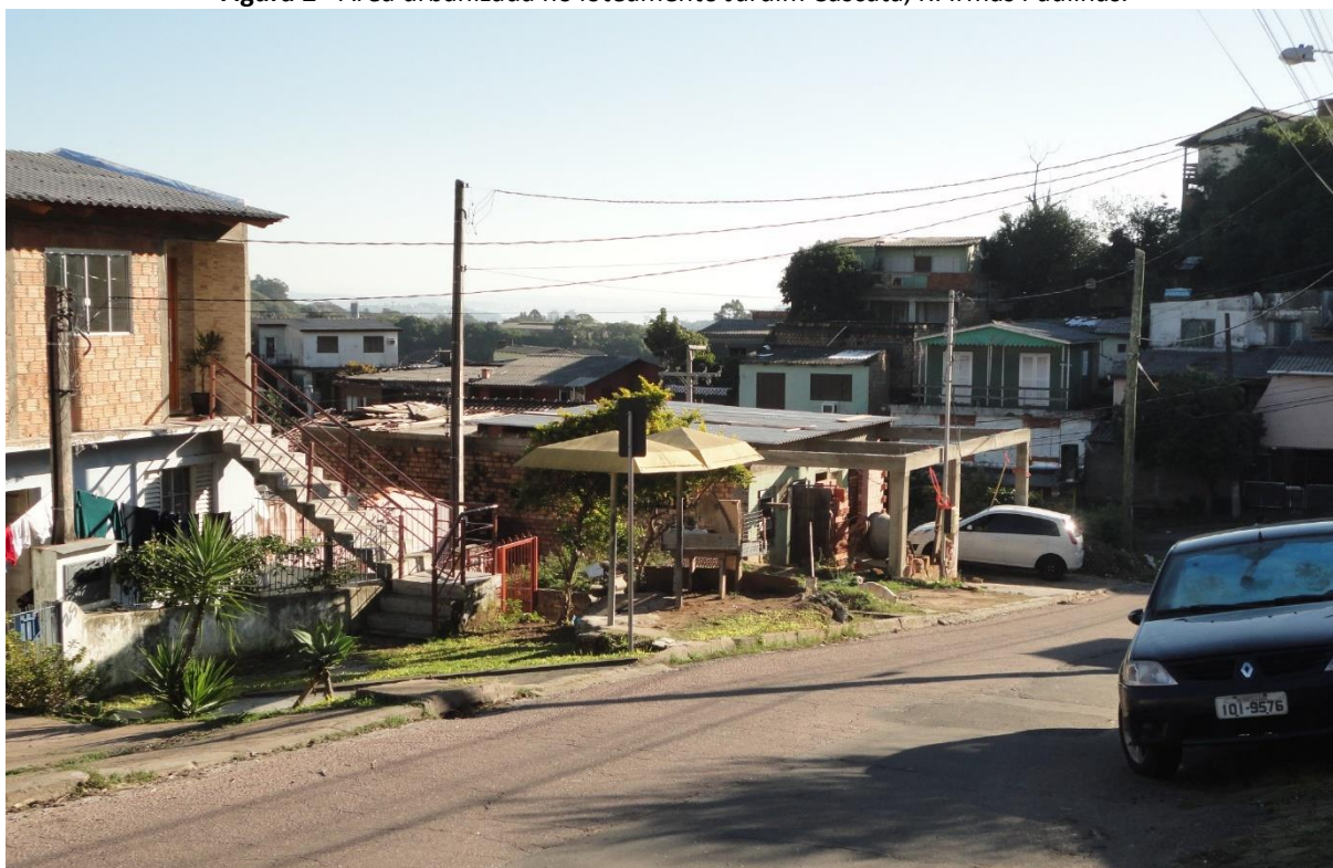
Figura 2 - Área urbanizada no loteamento Jardim Cascata, R. Irmãs Paulinas.
