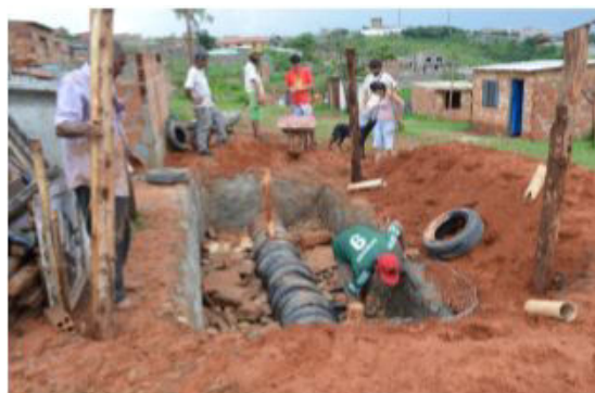
Figura 11: Construção do Tanque de Evapotranspiração - TVAP, fonte: Acervo da Equipe de Comunicação do MLB, 2012
