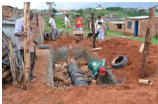
Figura 11: Construção do Tanque de Evapotranspiração - TVAP, fonte: Acervo da Equipe de Comunicação do MLB, 2012
