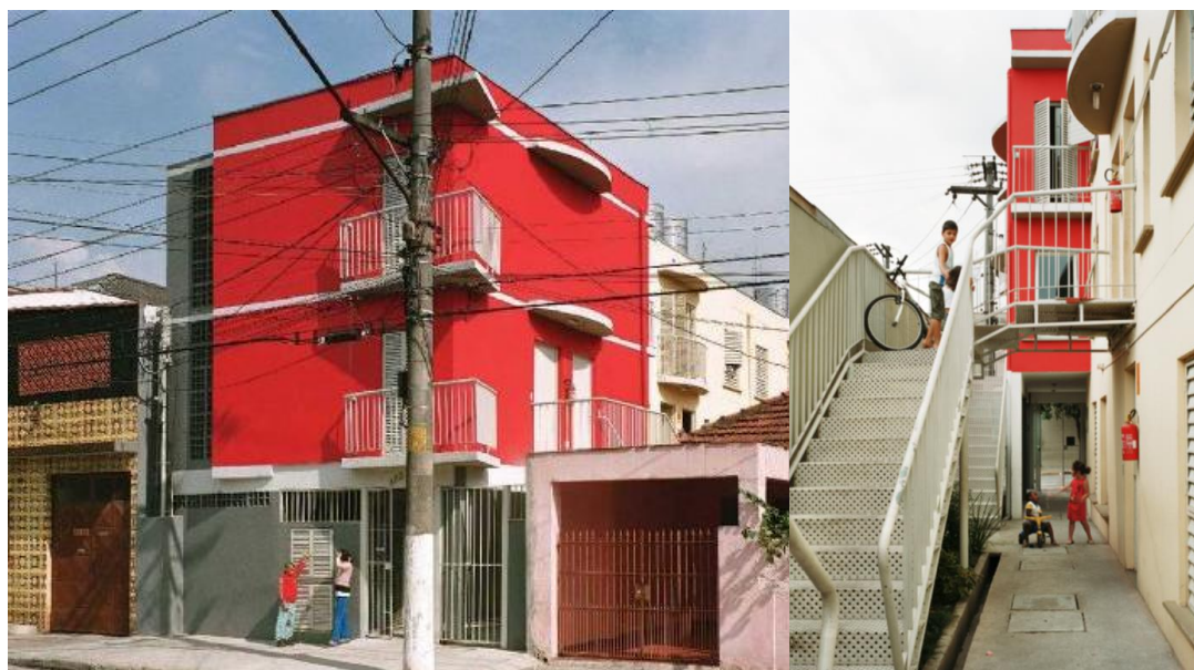
Figura 12 - Edifício Residencial Pedro Fachini – COHAB-SP. Fonte: GEROLLA, 2009, p. 30-31. Foto: Nelson Kon.
