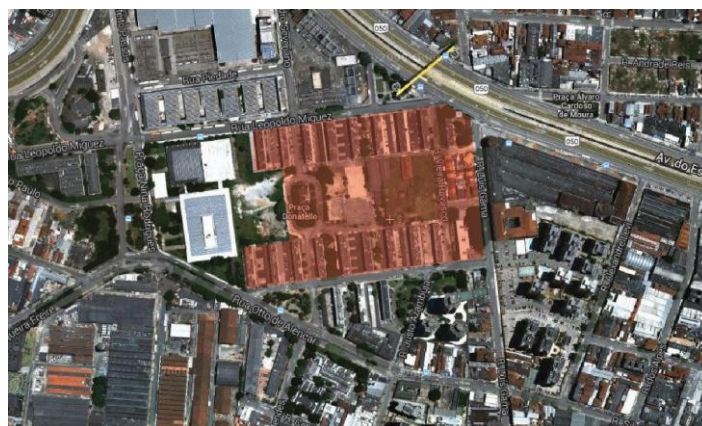
Figura 1: Conjunto Várzea do Carmo – Inserção Urbana Fonte: www.googlemaps.com - Acesso: 28/09/2014
