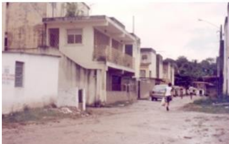
Figura 29 - Conjunto Habitacional Curado III. Acréscimos realizados pelos moradores ao lado dos edifícios (ao fundo). Fonte: MONTEIRO, 2000.
