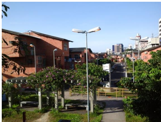
Figura 25 - PROSAMIM: Parque Residencial Manaus, Quadra Bairro 3.
