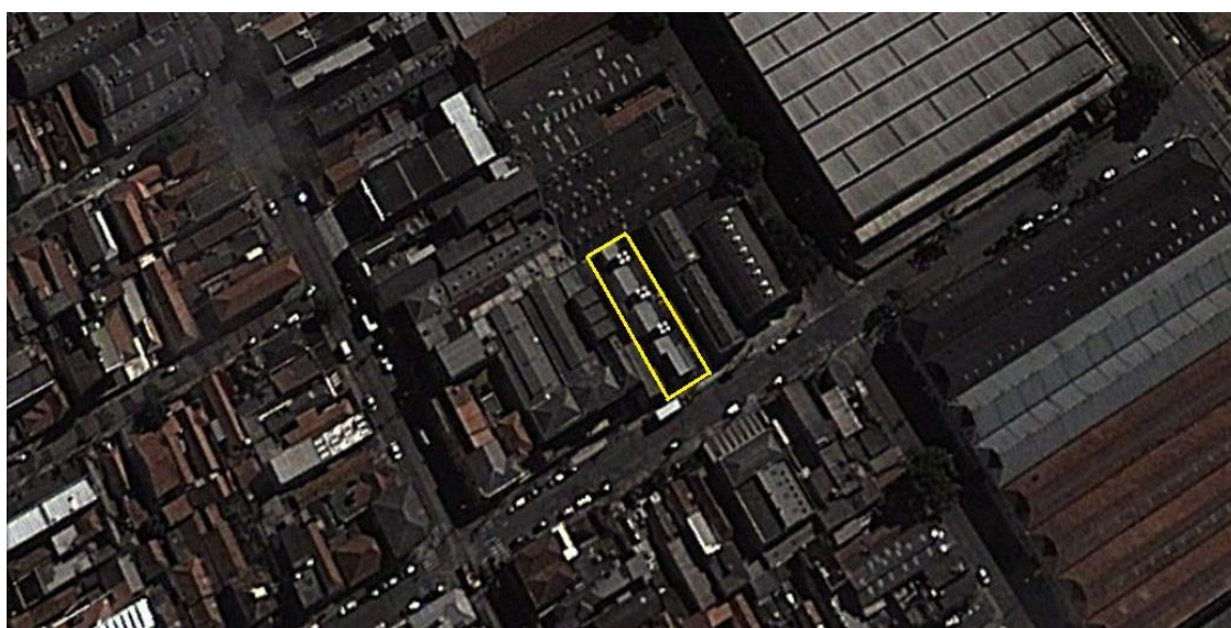
Figura 14 - Edifício Residencial Pedro Facchini – COHAB-SP: inserção urbana. Fonte: Google Maps, 2014.
