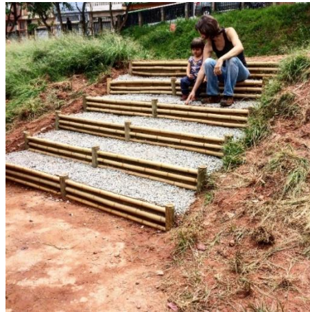
Figura 23 e 24: Construção da escada/arquibancada para o campo de futebol. Fonte: Autor
