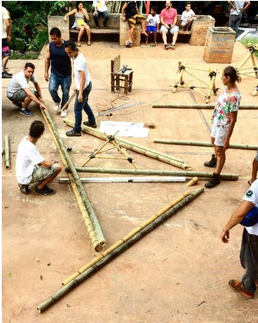
Figuras 19: Início dos trabalhos da construção da tesoura de bambu. Fonte: Autor
