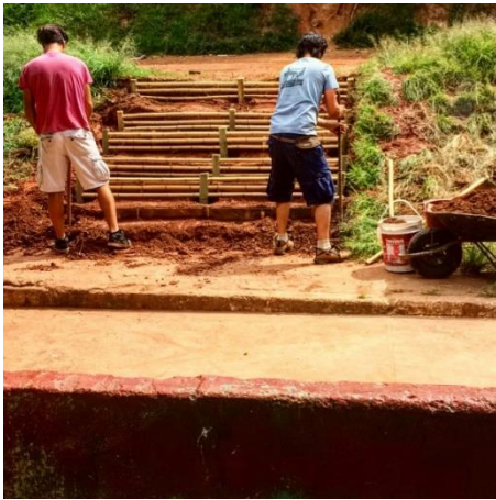
Figura 23 e 24: Construção da escada/arquibancada para o campo de futebol. Fonte: Autor
