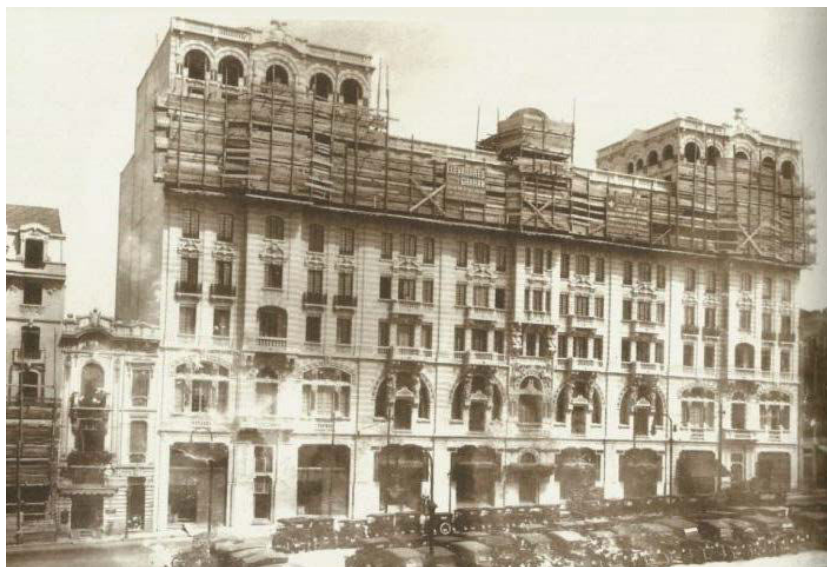
Figura 4: Foto da fachada em construção, acabamento dos andares superiores.
