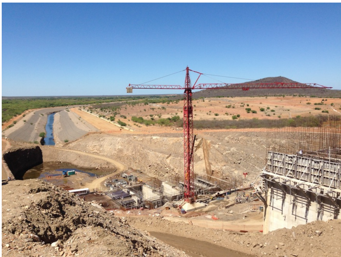
Figura 7 - Captação do Eixo Norte, em Cabrobó, e estação de bombeamento (EBI-1) em obras (foto de uma das autoras do artigo, 2013). Cabrobó: julho de 2013.
