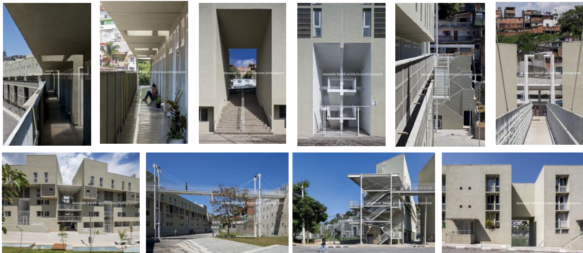
Figura 13: Fotos dos elementos de circulação, vertical e horizontal, do conjunto Santo Amaro V. Fonte: Leonardo Finoti - Architectural Photographer.
