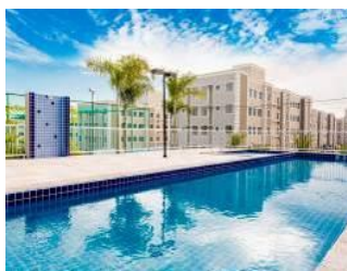
Figura 9: Equipamentos e espaços da área de lazer de um empreendimento voltado para a faixa 02 de renda. Residencial Jangadas e Caravelas em Nova Parnamirim. Fonte: Site da Construtora MRV, 2014.
