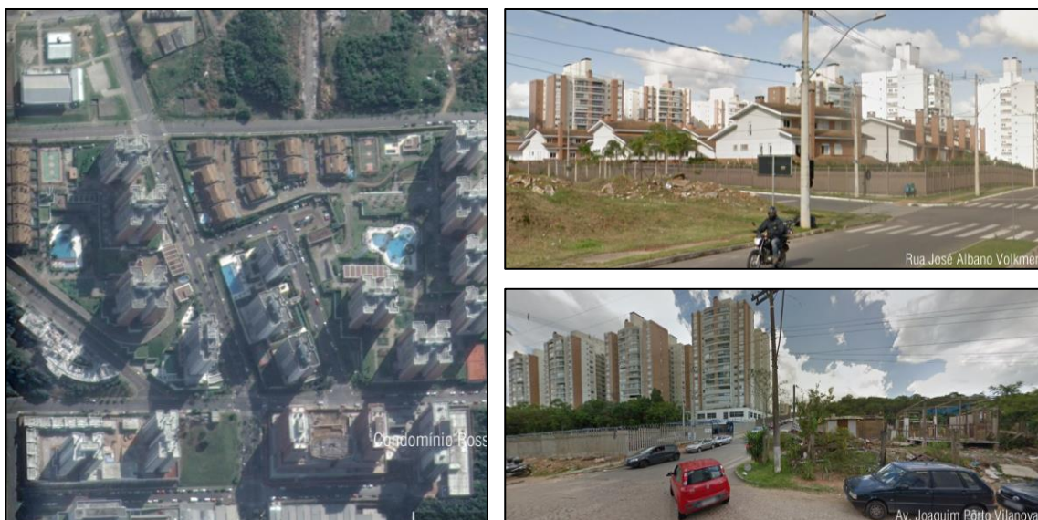
Figuras 11, 12 e 13 – Condomínio Rossi Panamby
