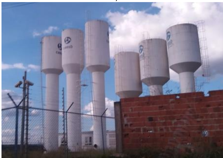
Figura 6. Exemplo de EPU: caixas d'água da CAESB no Setor Habitacional Água Quente, RA Recanto das Emas, DF.
