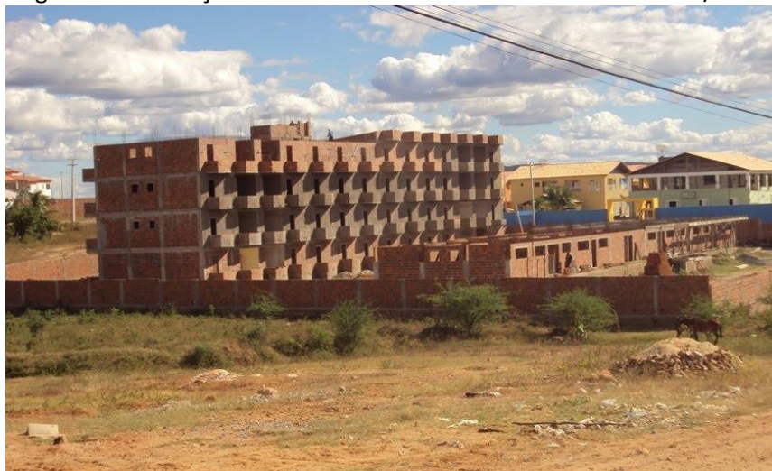
Figura 3: Construção Prédio Residencial em Pau dos Ferros – RN/Brasil
