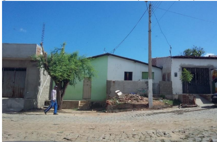
Figura 09. Vias do Ato da Tubiba com pavimentação precária.
