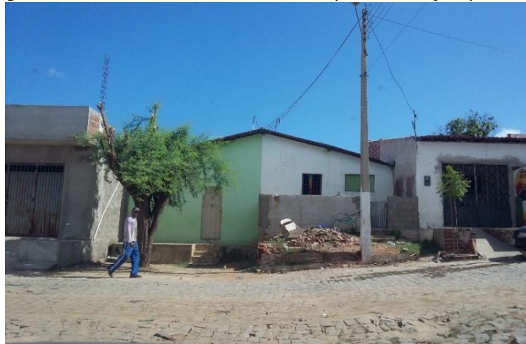
Figura 09. Vias do Ato da Tubiba com pavimentação precária.
