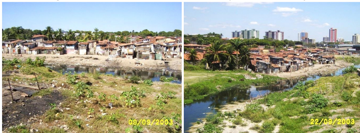
Figura 1 – Comunidade Maravilha e o Riacho Tauape antes da intervenção
