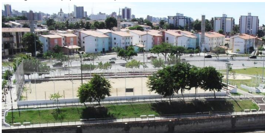
Figura 3 – Equipamentos esportivos no Setor IV e Setor III ao fundo
