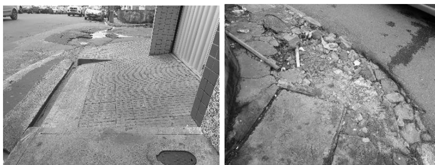
Figura 18 e 19. Rampa para carro e estrutura do passeio comprometida.
