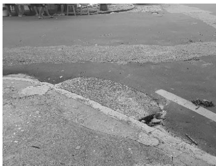
Figura 20. Rampa para pedestre.
