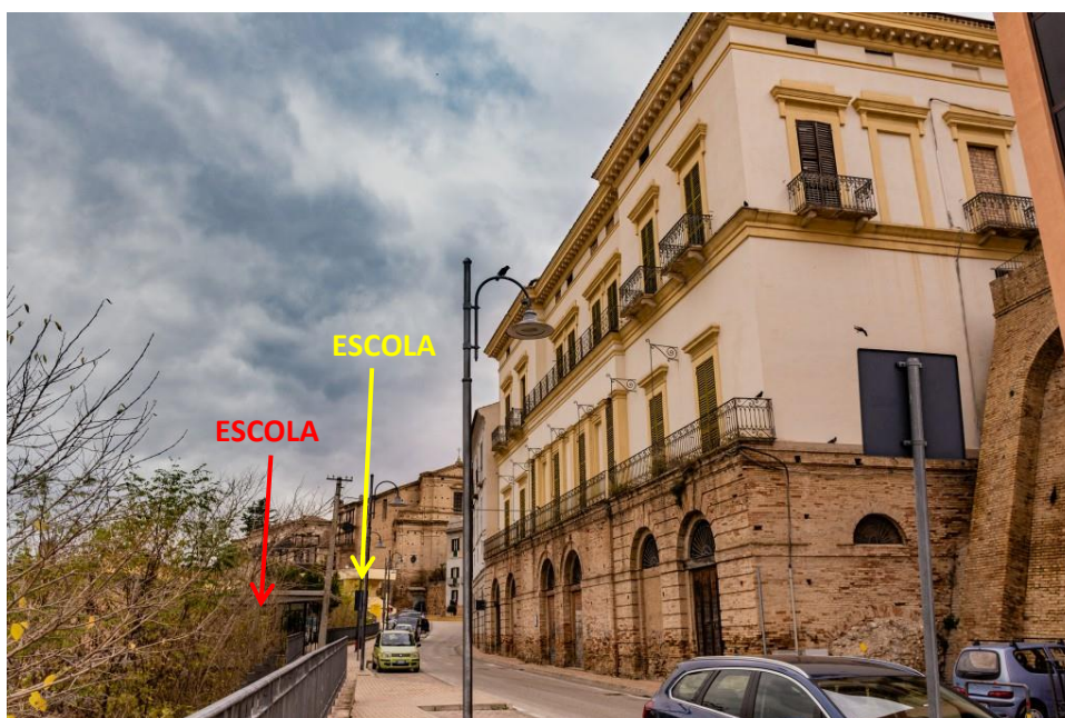
Figura 08: Vista da cidade, com destaque para a inserção das escolas (em arquitetura contemporânea), sem interferir na leitura do conjunto histórico.
