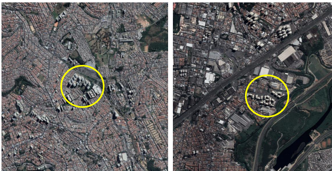
Figuras 09 e 10: áreas de inserção do Cidade Maia e do Único Guarulhos , destacados em amarelo. Fonte: Google Earth, 2017.
