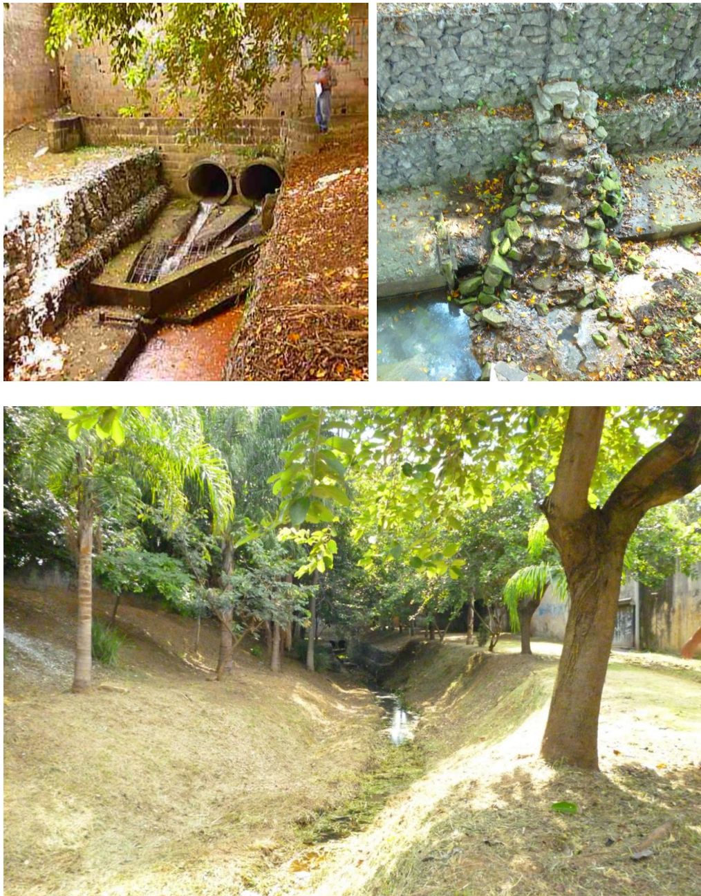
Figura 3: (acima à esquerda) no ponto a montante da intervenção onde o trecho em canal fechado é sucedido pelo trecho em canal aberto e as derivações que foram implantadas separando a drenagem urbana do curso d'água alimentado pelo lençol freático e nascentes existentes (Figura 4). Figura 5: O Córrego Queromano após intervenção. Fonte: Autores.
