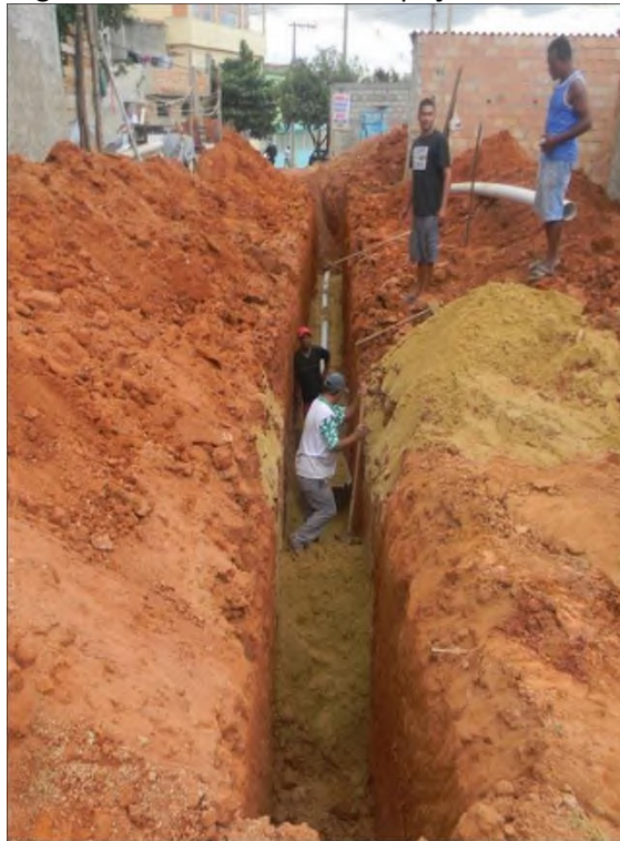
Figura 15 – Autoconstrução de rede convencional de esgotamento sanitário na ocupação Eliana Silva
