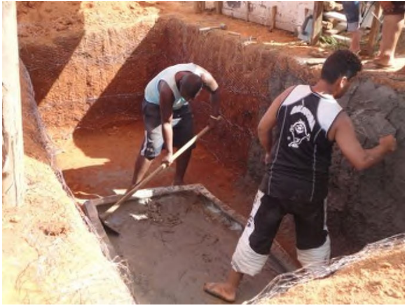
Figura 14 - Aplicação de argamassa no primeiro tevap da ocupação Eliana Silva em 05 de dezembro de 2012
