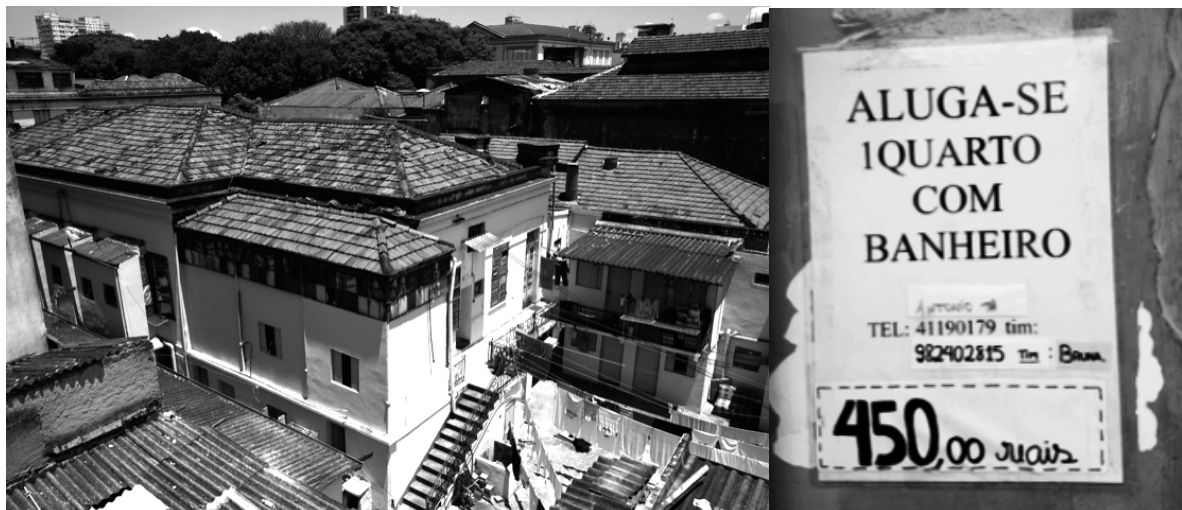
Figura 2: Vilas e conjuntos de casas construídas para locação, subdivididas para acomodar um número cada vez maior de moradores, em condições que se deterioravam em função da densidade. Fonte: LOPEZ et al , 2010
