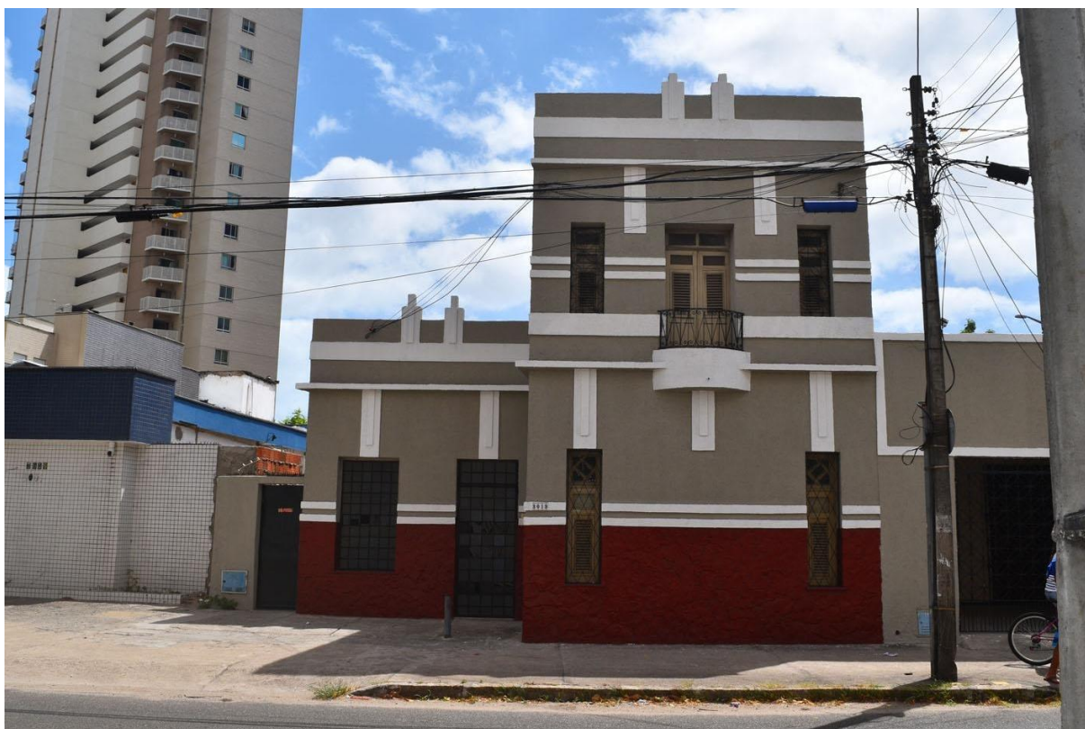
Figura 11: Um dos poucos sobrados na avenida, com fachada alterada e elementos que lembram o art déco . Ao fundo, uma das novíssimas torres de apartamentos.
