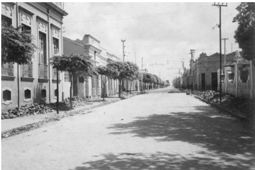
Figura 3: O casario da Visconde, ao lado do Parque da Liberdade. A fotografia retrata obras, provavelmente do final dos anos 1940.
