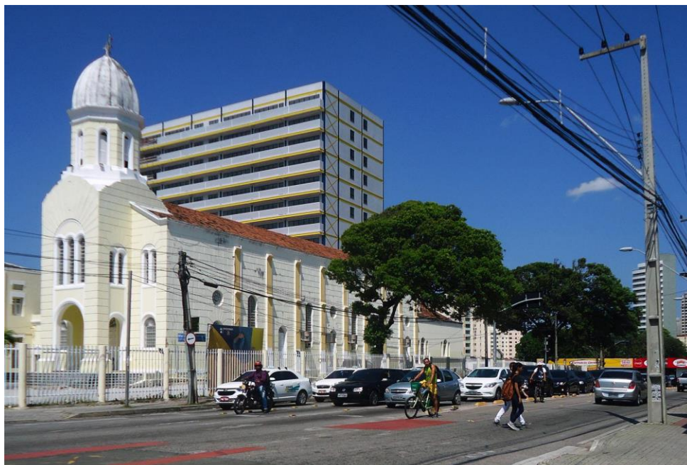
Figura 16: Capela do antigo Colégio das Dorotéias, a partir do cruzamento das Avenidas Visconde do Rio Branco e Domingos Olímpio. Ao fundo, sobressai uma nova torre, construída já após o tombamento do Colégio.
