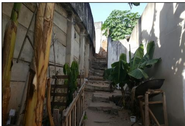
Figura 05. Escadaria de acesso à comunidade, antes da reforma. Motyrum Urbano. 2016.
