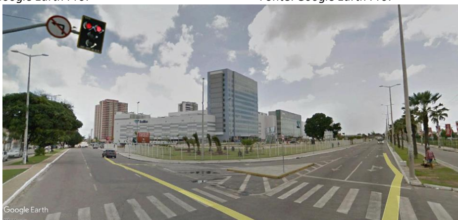
Figura 17 – Shopping RioMar Kennedy e torre comercial. Ao fundo, o empreendimento Boulevard Shopping Residence . Fonte: Google Earth Pro .
