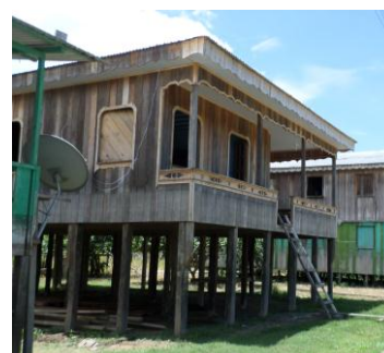
Figura 5 - Padrão arquitetônico habitacional, Anamã/AM.
