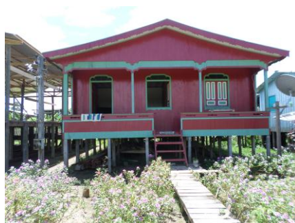
Figura 4 - Padrão arquitetônico habitacional, Anamã/AM.
