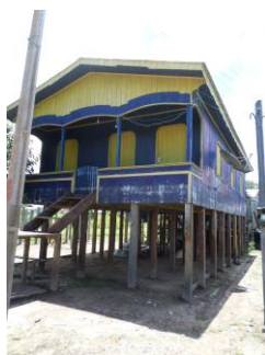
Figura 3 - Padrão arquitetônico habitacional, Anamã/AM.
