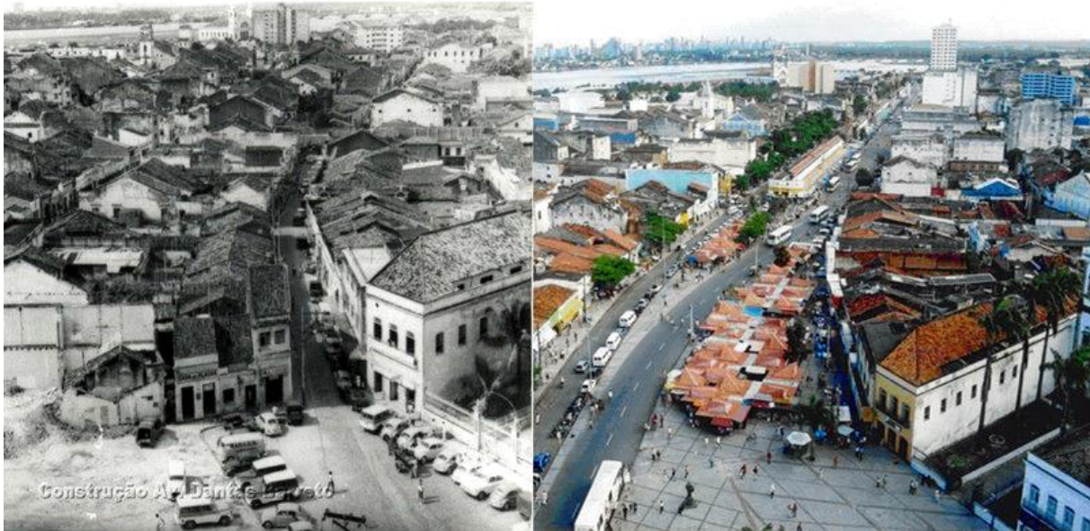
Figura 4 - São José no início da demolição e atualmente, com a Avenida Dantas Barreto
