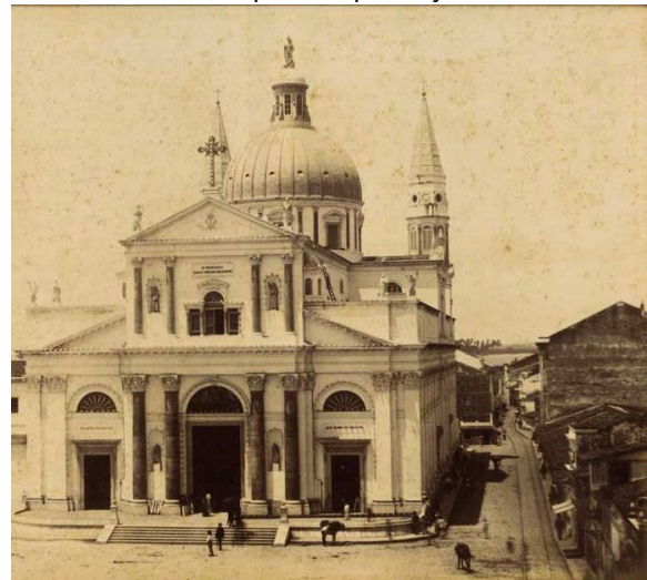
Figura 3 - Basílica de N. S. da Penha e entorno após a implantação dos trilhos
