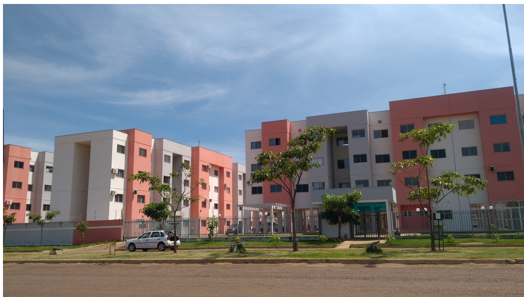
Figura 11 – Edifício vertical em Palmas Sul.
