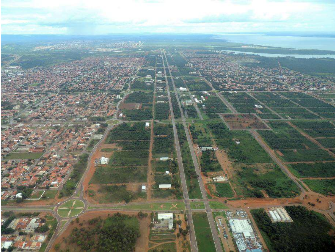
Figura 3: Imagem aérea da área do projeto urbanístico de Palmas na atualidade, demonstrando a escassa ocupação nos lotes lindeiros à proeminente Avenida Teotônio Segurado.
