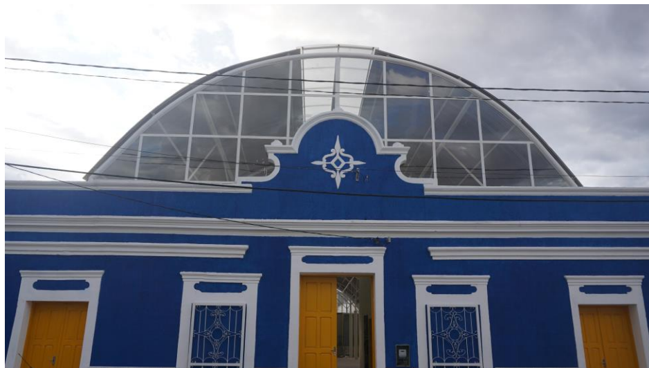
Figura 05: Mercado Público Municipal após a reforma em sua estrutura
