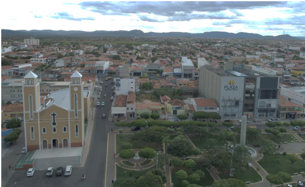
Figura 06: Relação Igreja, Obelisco e Shopping Center no centro de Pau dos Ferros, onde se percebe a monumentalidade das edificações com relação aos prédios comerciais e residenciais da cidade.
