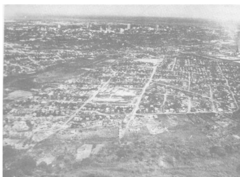
Figura 12: Ocupação irregular Pedregal e, ao fundo, o centro da capital, com incipiente processo de verticalização, 1977. Fonte: Cuiabá, 1980, p. 71.
