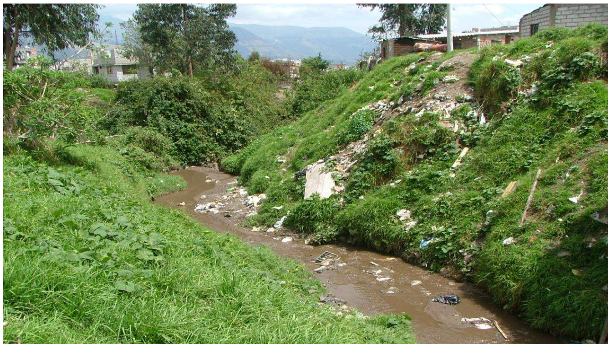
FIGURA 02 – Vista da quebrada (talvegue) antes da limpeza.
