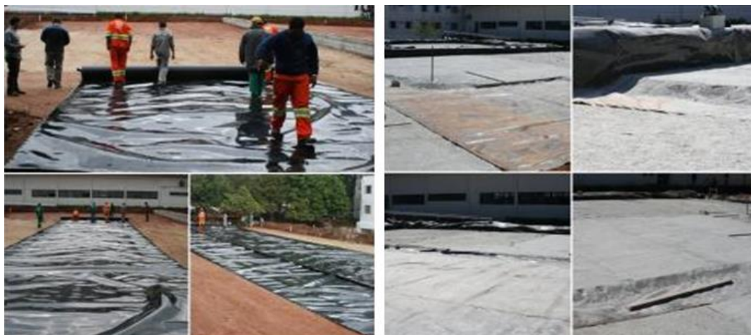
Figura 14: Assentamento de geomembrana
