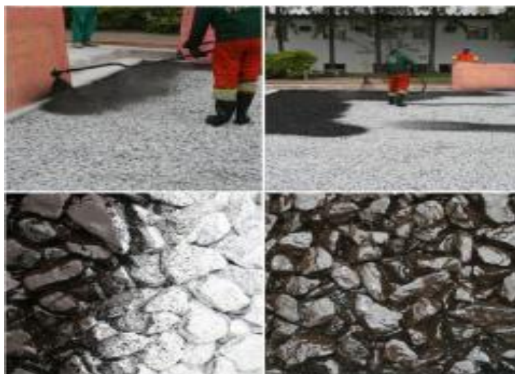
Figura 17: Aplicação de imprimação
