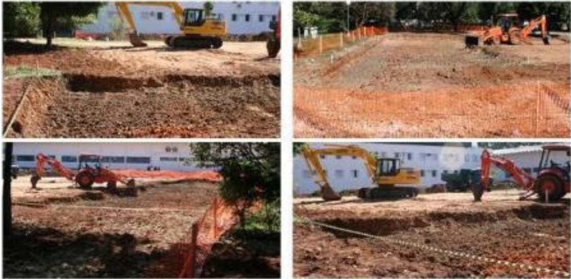
Figura 11: Abertura e preparo de caixa
