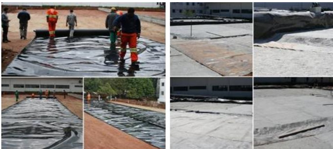
Figura 14: Assentamento de geomembrana
