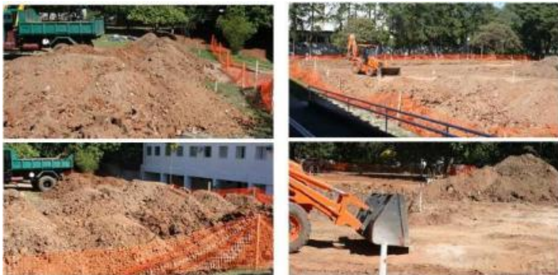
Figura 12: Terraplanagem - preparação para o aterro
