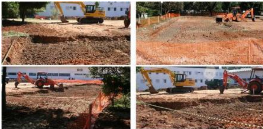
Figura 11: Abertura e preparo de caixa
