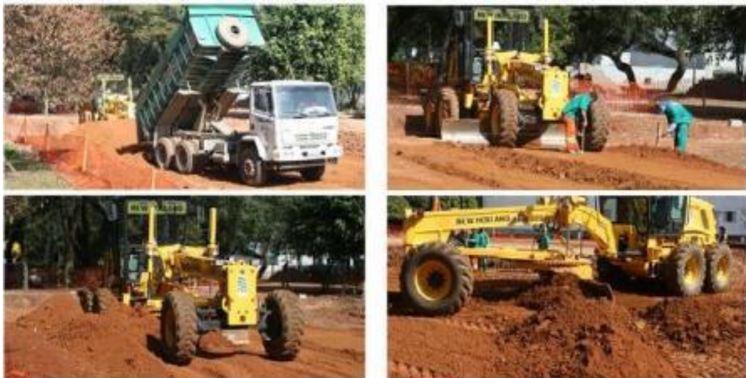
Figura 13: Espalhamento e nivelamento de solo para reforço
