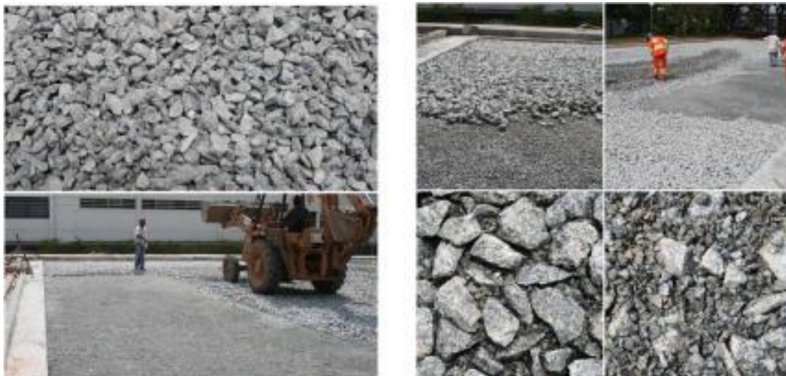
Figura 16: Execução da camada de macadame betuminoso
