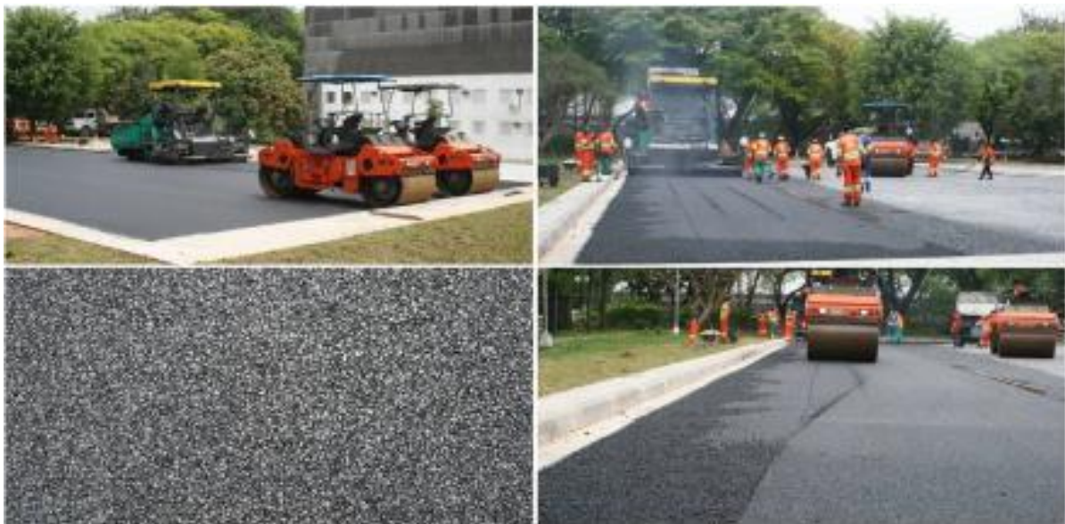
Figura 18: Execução do revestimento
