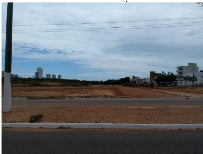
Figura 9 – Serviço de terraplanagem para implantação de um condomínio residencial na Zona de Proteção Ambiental 5.
