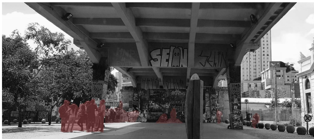
Imagem 13: Usos sociais no baixo do Viaduto Santa Tereza
