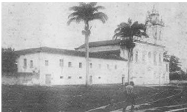
Figura 7: Conjunto Carmelita em 1906 antes da reforma Fonte: Severiano (1907).
