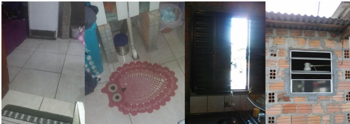
Figura 11: Imagens do piso colocado, das novas esquadrias e da rede hidráulica instalada. Fonte: ASCPOA.
