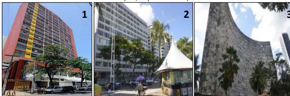
Figuras 01, 02 e 03: Primeiros edifícios residenciais de Boa Viagem em Recife. (Califórnia - 1, Acaiaca - 2 e Holiday - 3, respectivamente)
