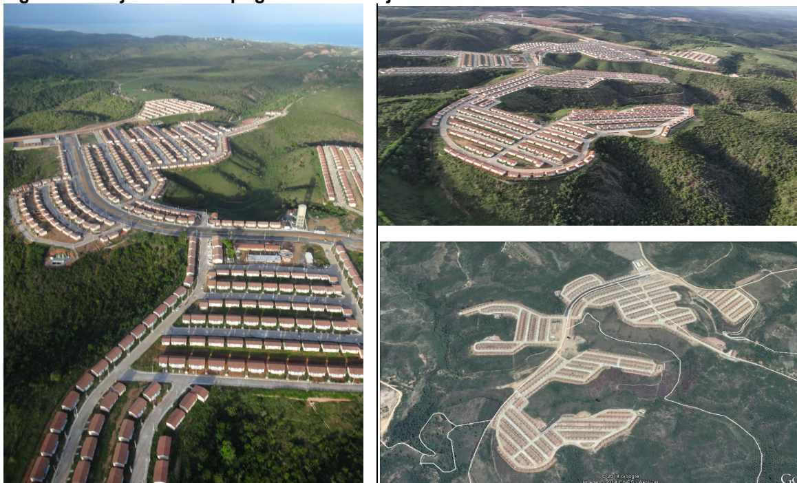
Figura 2: Conjunto José Aprígio Vilela - Conjunto habitacional horizontal.
